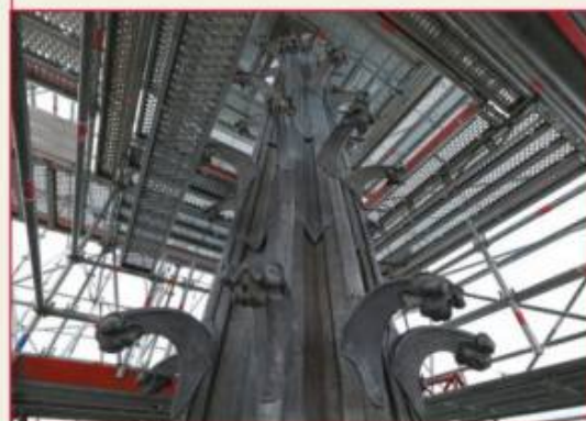
Installation de la nouvelle flèche.
