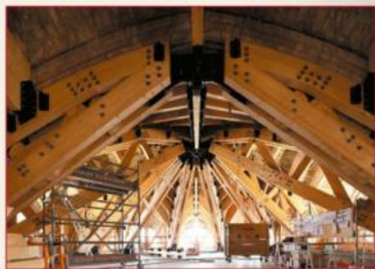
De juillet 2020 à août 2021, consolidation des voûtes.
