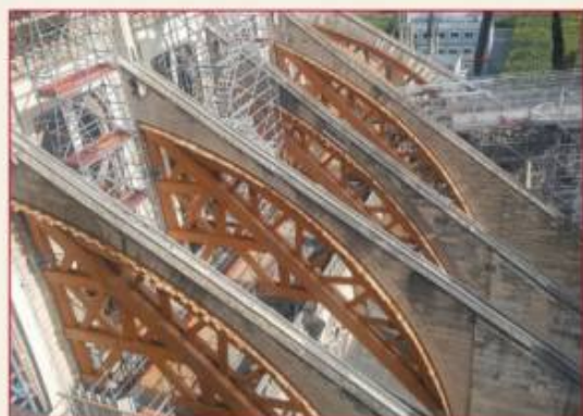
De juillet à décembre 2019, cintrage des arc boutants. 51 cintres mis en place.
