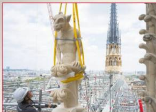
En septembre 2023, repose des gargouilles et chimères. Ci-dessus, l'une des cinq chimères endommagées, resculptées, puis remises à leur place.
