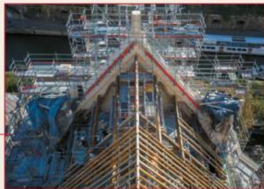
Automne 2022, nouvelle charpente.
