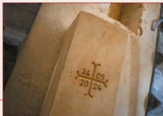
D'avril à mai 2024, pose des dernières pierres de la voûte.
